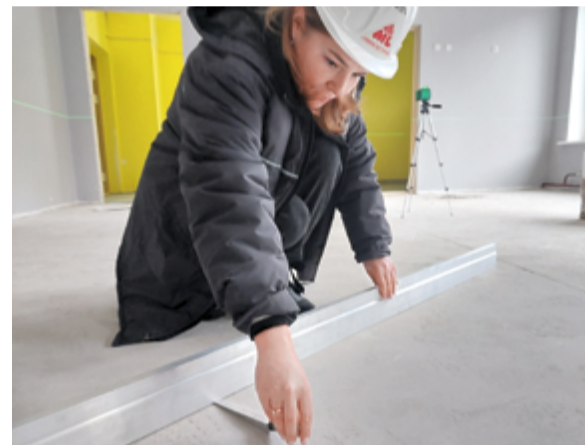
На фото: ведущий инженер сектора по контролю качества ГПО «Минскстрой» Татьяна ВИТКОВСКАЯ на приёмке детского сада в Боровлянах.
