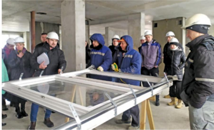
в дальнейшем промерзания окон и затекания особое внимание обращено на мероприятия, исключающие попадание влаги в монтажные швы в узлах примыкания оконного отлива к проему и коробке окна. Рассмотрены отклонения при выполнении таких работ.
