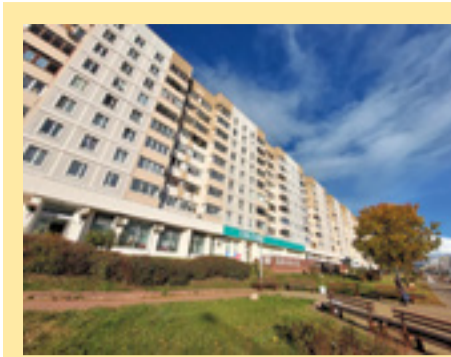
СУ-94 треста № 1 завершает работы на самом крупном объекте капремонта ГПО «Минскстрой» – жилом доме по ул. Притыцкого, 78 общей площадью 48 153 «квадрата». Это первый опыт строителей
