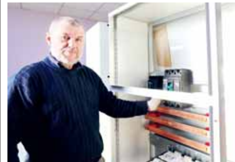
Мариан Волейня, электромонтажник 5 разряда
