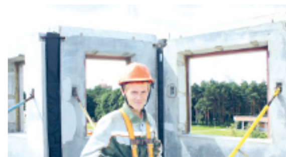
Монтажник строительных конструкций СУ-207 ОАО «МАПИД» Ян Карбанович
