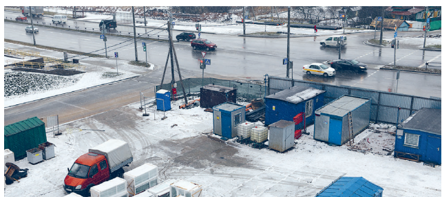
Стройплощадка жилого дома в границах улиц Притыцкого-Скрипникова-Одинцова-Лобанка (СУ-101 ОАО «МАПИД»)
