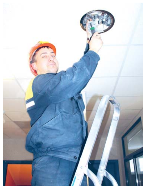
Сергей Воскалей, электромонтажник УСП ОАО «Стройтрест №1»
