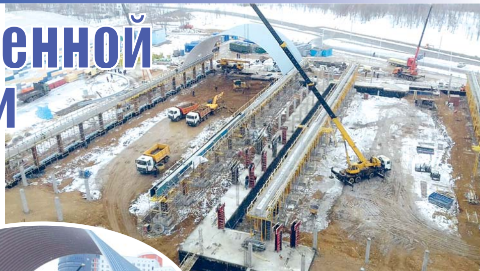
На строительной площадке кипит работа. Возводятся арочные конструкции.
