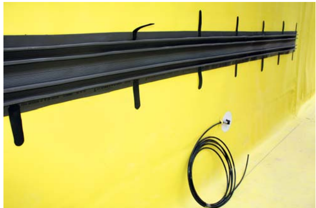
Гидрошпонки и штуцеры с инъекционными вводами
