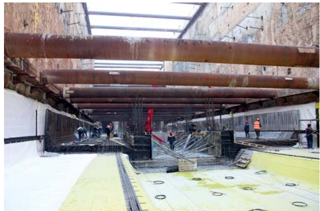
Гидроизоляция ПВХ мембранами лотковой части и стен котлована станционного комплекса «Юбилейная площадь»
